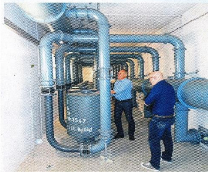
Im Bunker in der Rathaus Tiefgarage: Bürgermeister Dr. Wolfgang Hell und Lehrer Thorsten Krebs (rechts) vor den Aktivkohlefiltern, mit denen die radioaktive Luft im Ernstfall dekontaminiert werden wäre. Foto: Pohl
